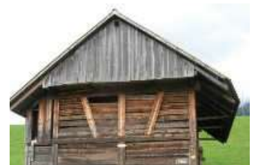
Kleine Scheune oben am Sanggenbühlweg
